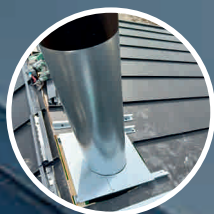
Vesikatolle tukilevyt pellityssarjan alle
