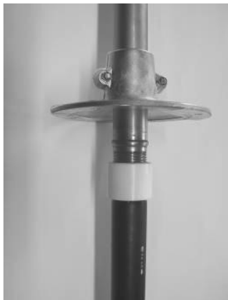
Kuva 8: Runkoputken kiinnitys nousuputkeen
