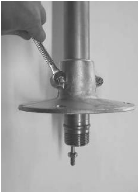
Kuva 6: Jalustalaipan kiinnitys
